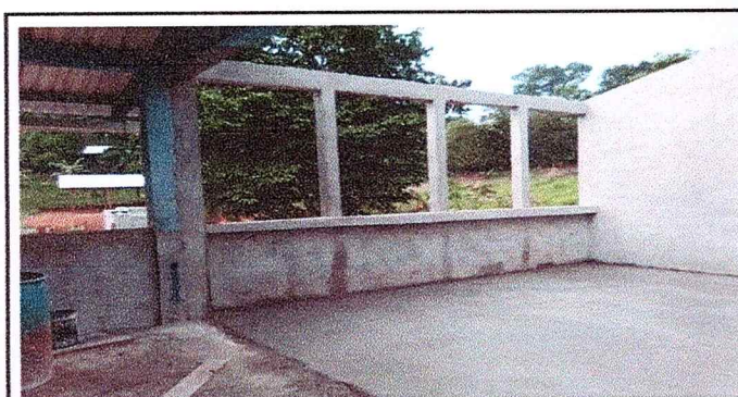
Foto 5: Mejoras en puertas y ventanas.
