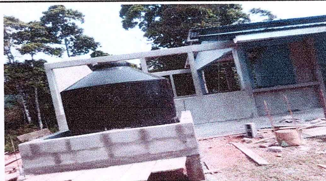
Foto 4: Mejoramiento de lavamanos múltiple.
